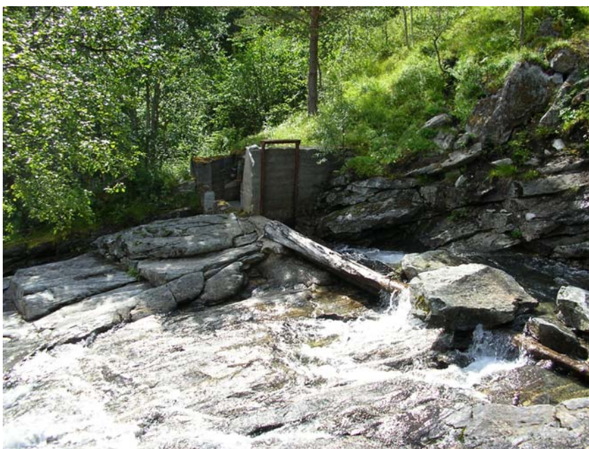
Figur 8: Rester etter gammelt kraftverksinntak i Erstadelva. (Foto: Dagmar Hagen)
